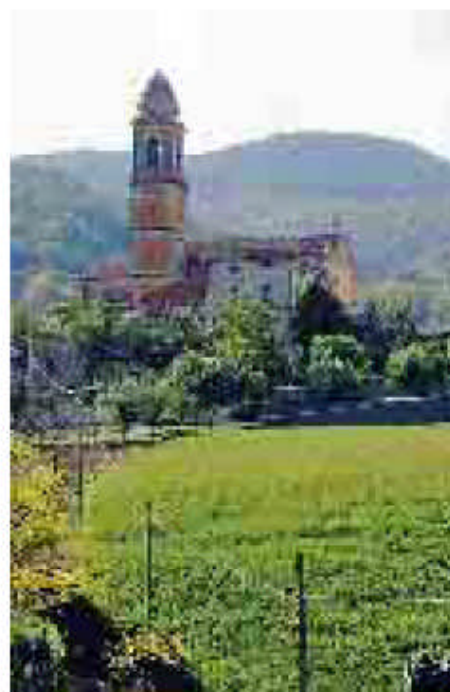
RIVERGARO - Il borgo di Rallio di Montechiaro: un vecchio pozzo che sfiata si trova all'ingresso del paese
